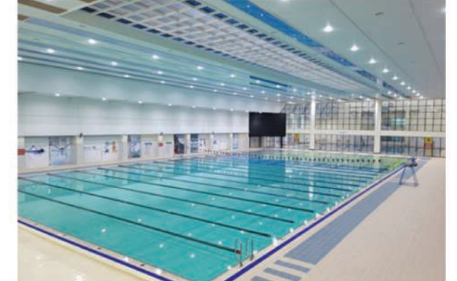
온도를 낮추지 않고 다량의 제습부하 처리가 필요한 수영장
