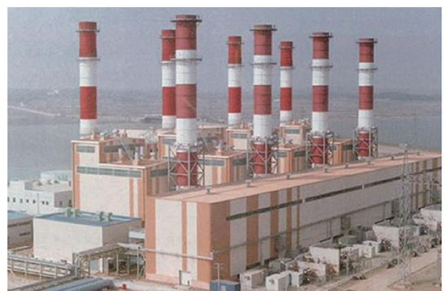
โรงผลิตไฟฟ้าที่ต้องทำงานในอุณหภูมิ 5-35 องศา เพื่อดูแลสาร iron oxide
